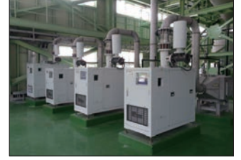
Sudokwon Çöp Sahası, (NX150), Kore
